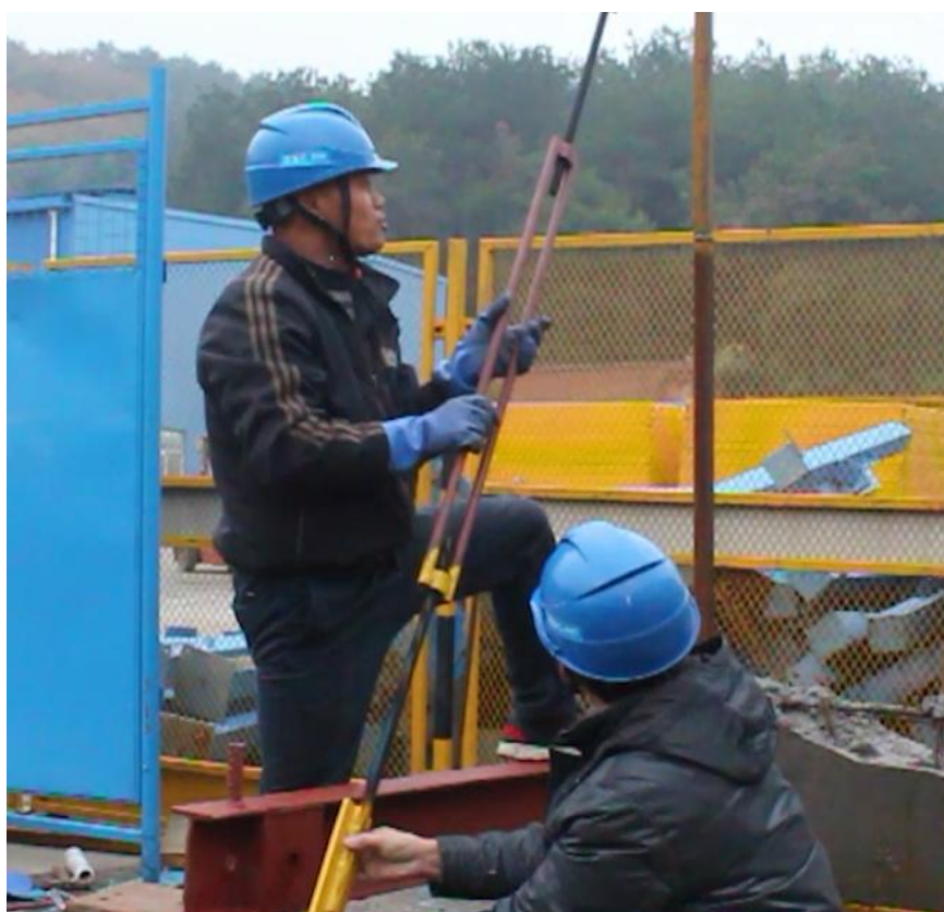
插图 斜拉杆安装
