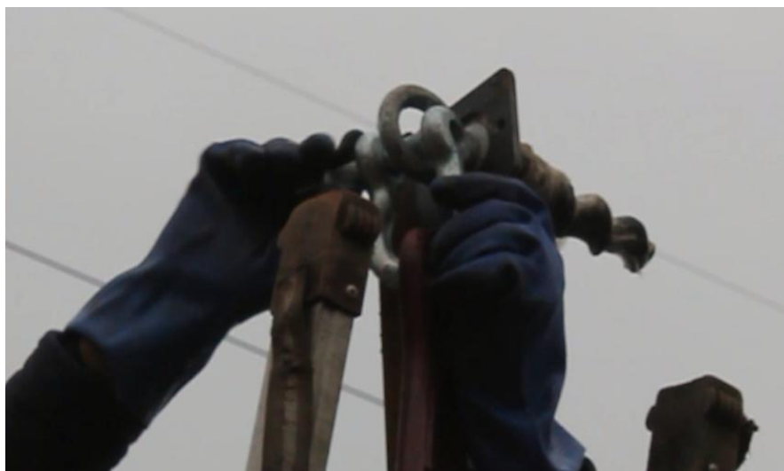
插图 预埋拉环螺栓
