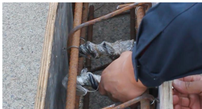
插图 预埋工字钢螺栓
