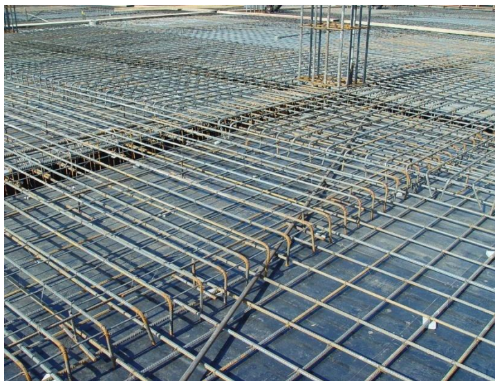
插图 筏板及楼板钢筋绑扎样板
