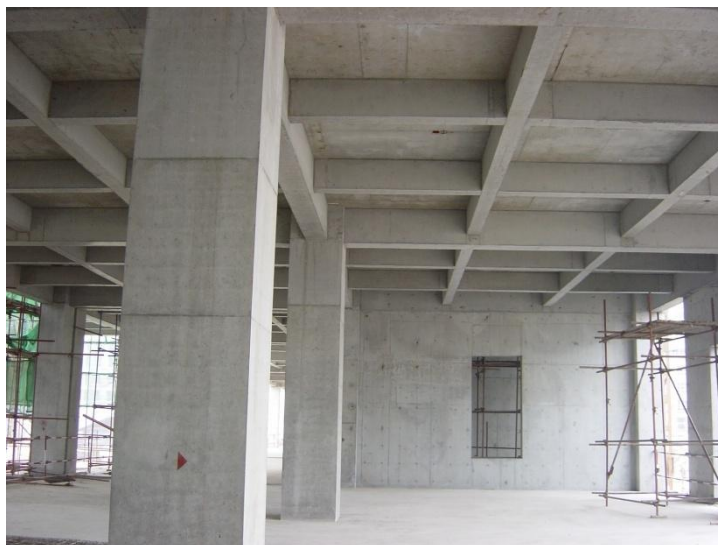
插图 主体结构样板
