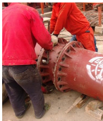
插图 钢支撑地面拼装
