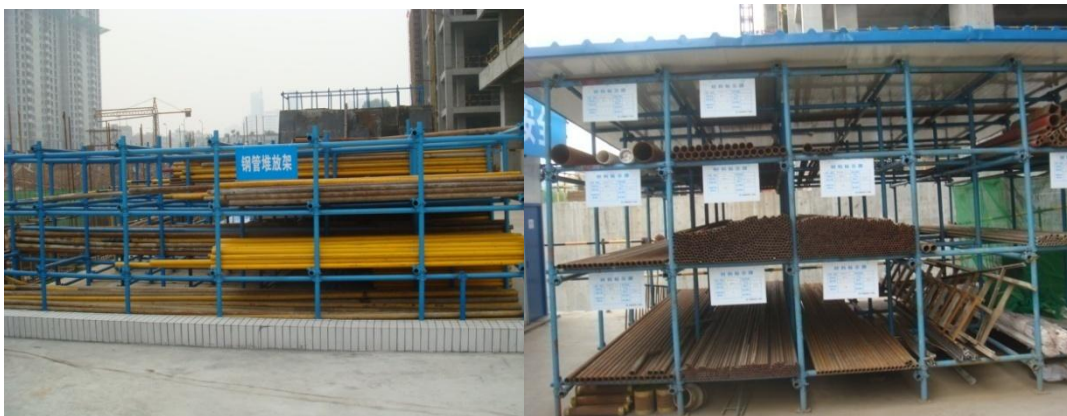
插图 钢管堆码与安装材料堆码
