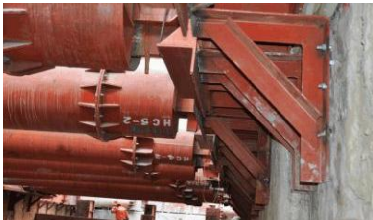
插图 牛腿施工
